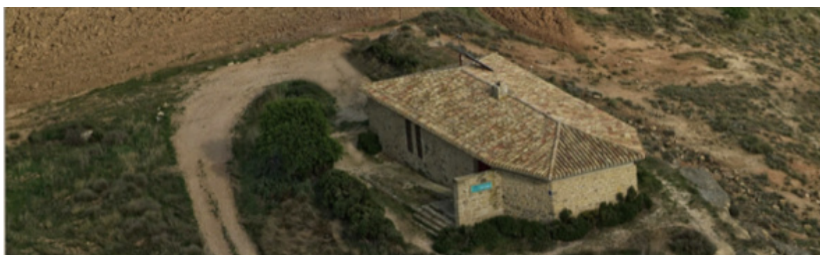
Vue aérienne du Bordon (cl. Observatoire Las Cañas)
