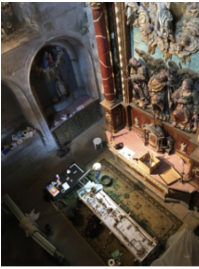
Une partie du chantier sous le sol de la cathédrale
