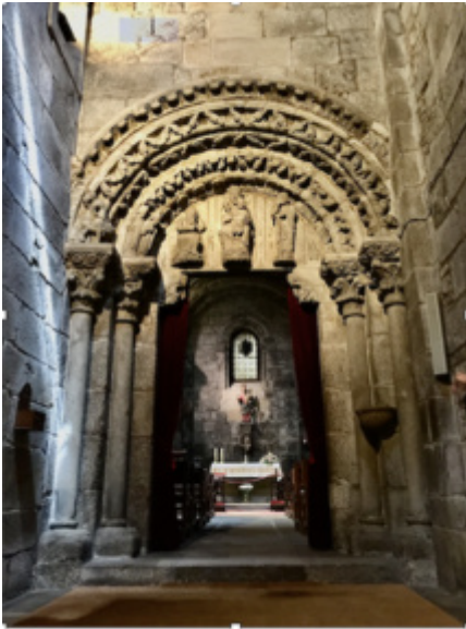
Incluse dans la cathédrale de Compostelle, l'église Santa María la Antigua de la Corticela (cliché DPM)
