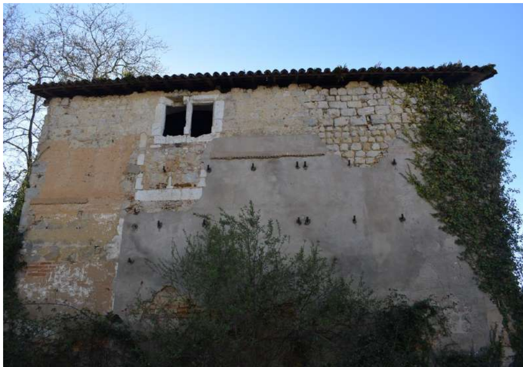
L'ancien logis abbatial transformé en grange (cliché de l'auteur)
